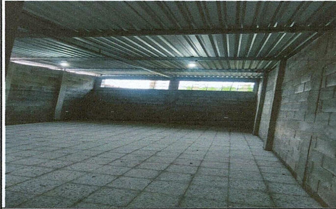
Foto 1: Interior de aulas.
