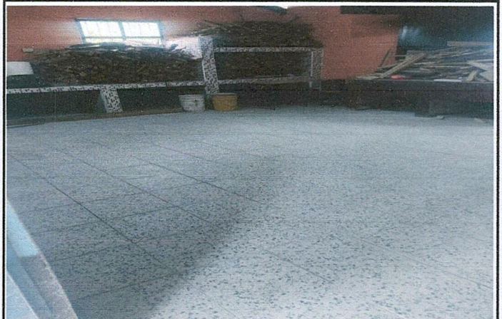
Foto 4: Finalización de la colocación del piso de granito de la cocina.
